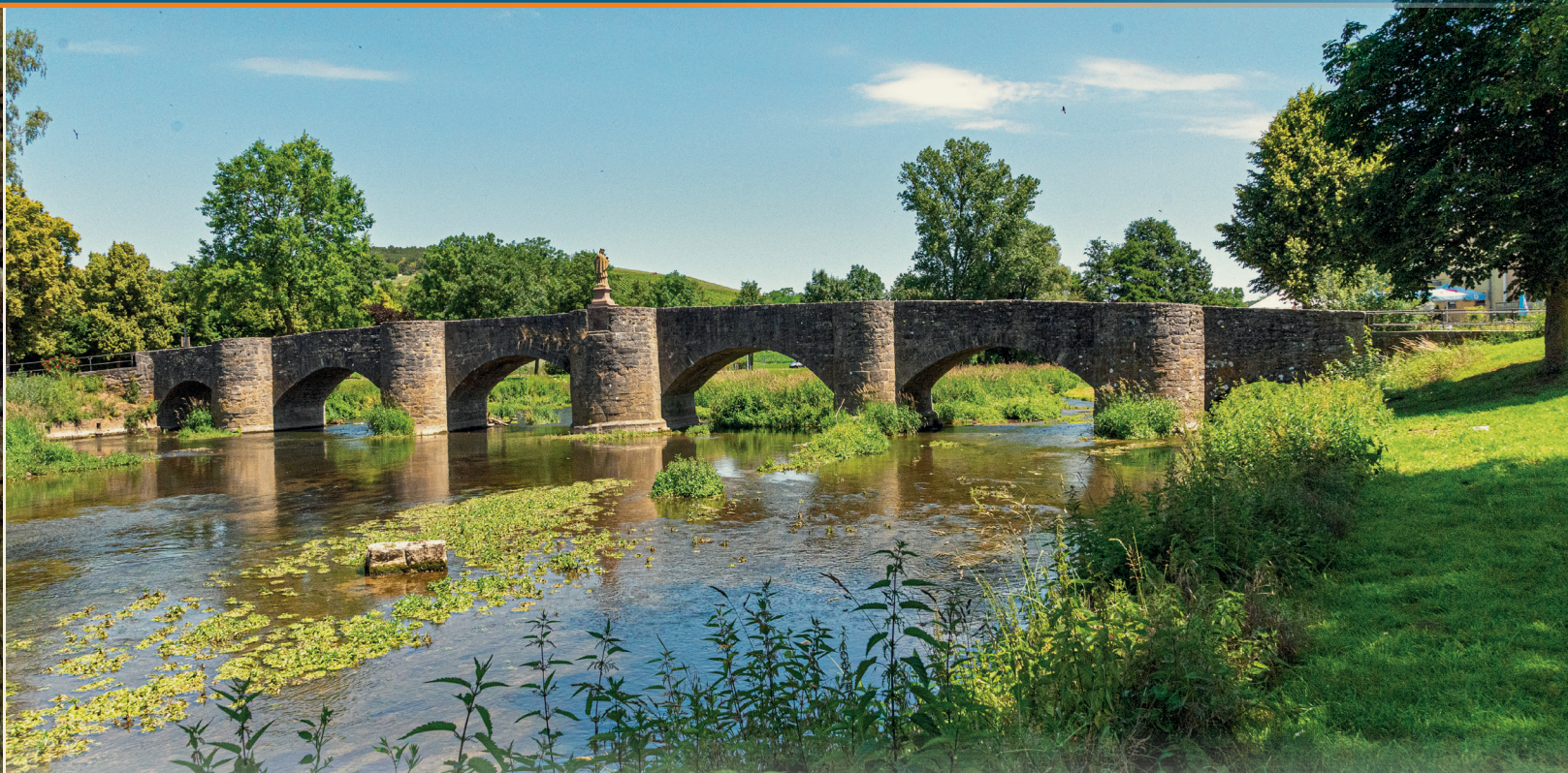
Brücke von Balthasar Neumann (Röttingen)
